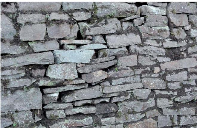
*Nach Entfernung der Wurzeln wird mit alten und neuen Steinen verfüllt und die Mauer gesichert.*
