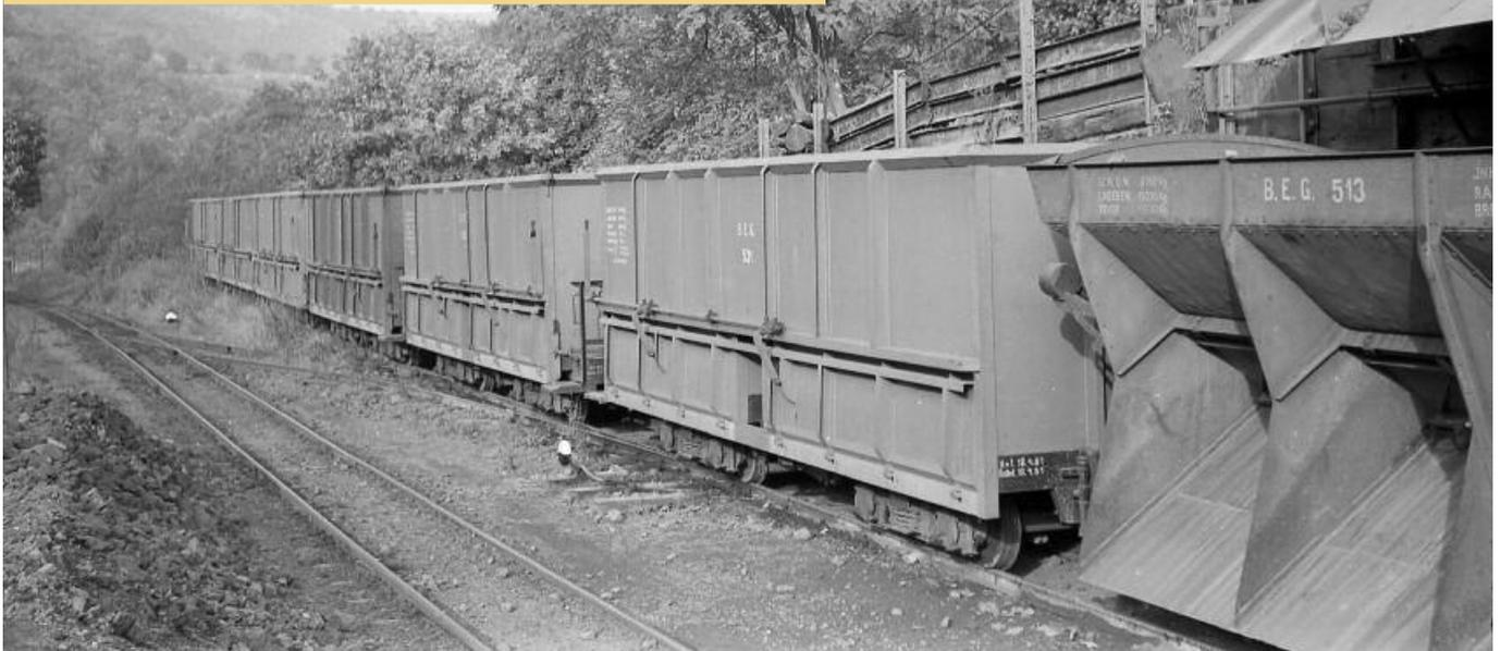
▲ In Schweppenburg Gbf steht der Leerpark aus sechs Schwefel-Wagen (Serie 521 bis 532 von 1960 / 61 mit 32 t Nutzlast) sowie rechts dem Herbrand-Wagen 513 (1951 ex Engelskirchen-Marienheider Eisenbahn, 15 t Nutzlast) zur Beladung unter der Sturzrampe bereit. Eine zweite Garnitur wird derweil im Rheinhafen entladen. Foto: Karl-Heinz Wipperfürth, 1961
