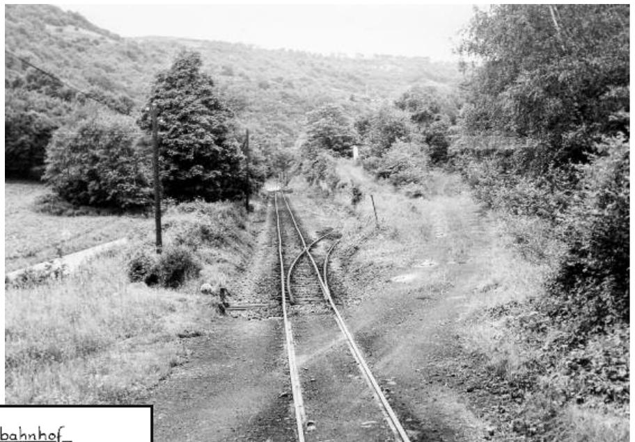
▼ Der Zustand der Anlagen im Jahr 1958 ist gut aus den in der SbV von 1967 enthaltenen Gleisplänen ersichtlich. Gleis 2 b wies ein Gefälle auf, sodass die Wagen auch ohne Lokomotive mittels Schwerkraft und Hemmschuh zur Rampe bewegt werden konnten.
