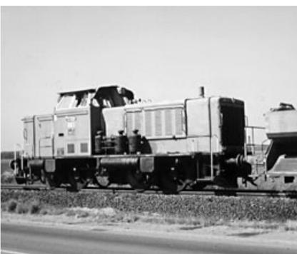
Loks der Typenreihe 800 D wurden bei der Ilse der Hütte im schweren Erz- und Sandverkehr eingesetzt. Lok 803 (Langversion mit zweiteiliger Motorhaube) vor einem Sandzug. Derartige Sandzüge dienten zum Verfüllen ausgegrabener Stollen und verkehrten von nahegelegenen Sandgruben aus. Zuglasten von 2000 t mit diesem Loktyp waren nicht selten.
