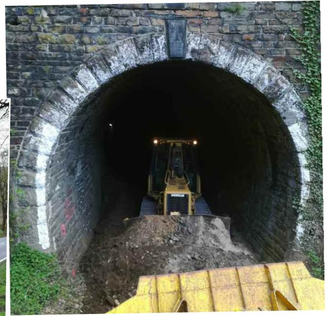
▲ Nach dem Abbau der alten Gleise konnte auch der alte Unterbau per Radlader zu den Tunnelportalen verbracht werden.
