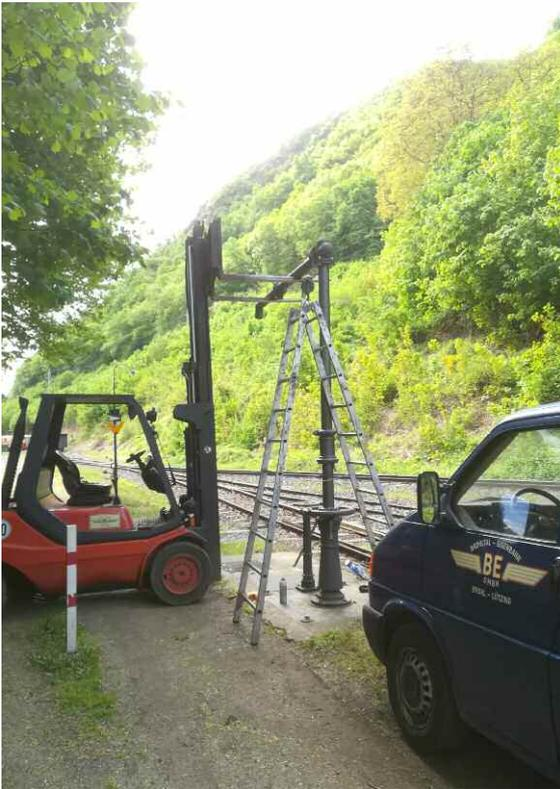
Der im Bahnhof Brohl BE installierte Wasserkran zur Versorgung unserer Dampflokomotive 11<sup>sm</sup> ist rechtzeitig zum Dampf-Saisonbeginn wieder voll in Betrieb. Nach einem Frostschaden musste der Kran zunächst abgebaut werden. Am 26. April konnte der Schaden behoben werden, sodass dem Wasser fassen nichts mehr im Wege steht.
