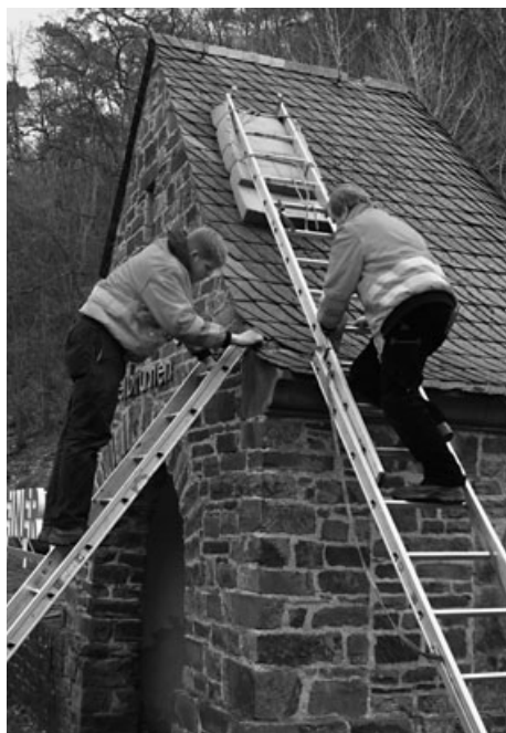
Martin Bickenbach und Uwe Meiß beim Austausch der beschädigten Schieferplatten des Gebäudes am Haltepunkt Schweppenburg am 23.02.2008
