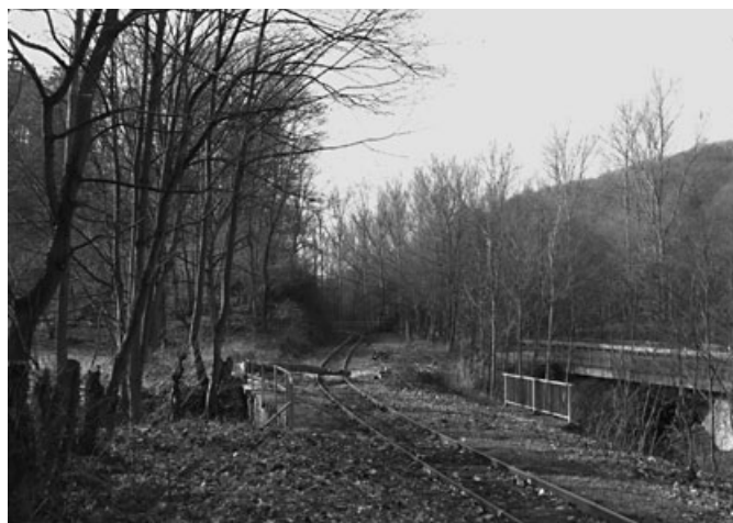
Freischnitt beiderseits des Haltepunktes am 23.02.08. Der gefälltte Baum muss noch zerschnitten werden.
