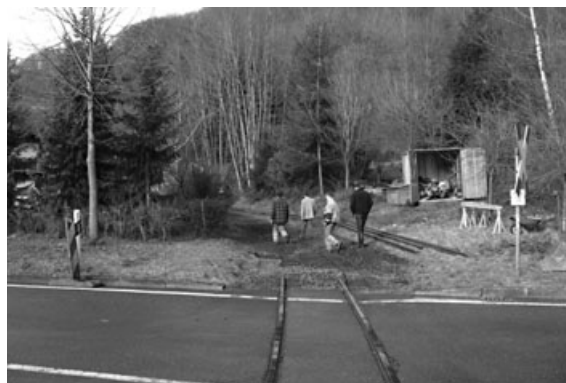
Bahnübergang km 1,655 – Deutlich zu erkennen der Bewuchs im linken Sichtdreieck. Aufgenommen am 13.03.2008
