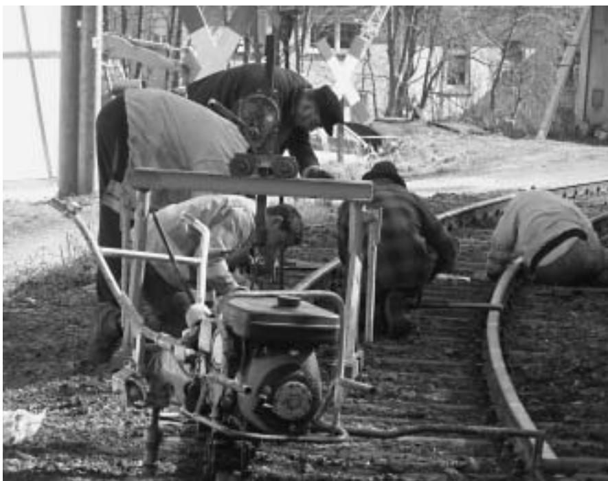
Spureinstellen und Verschrauben im Bereich Wagenschuuppen 21.03.09
