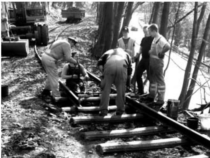
Austausch und Befestigung der Kleineisen am 03.04.09
