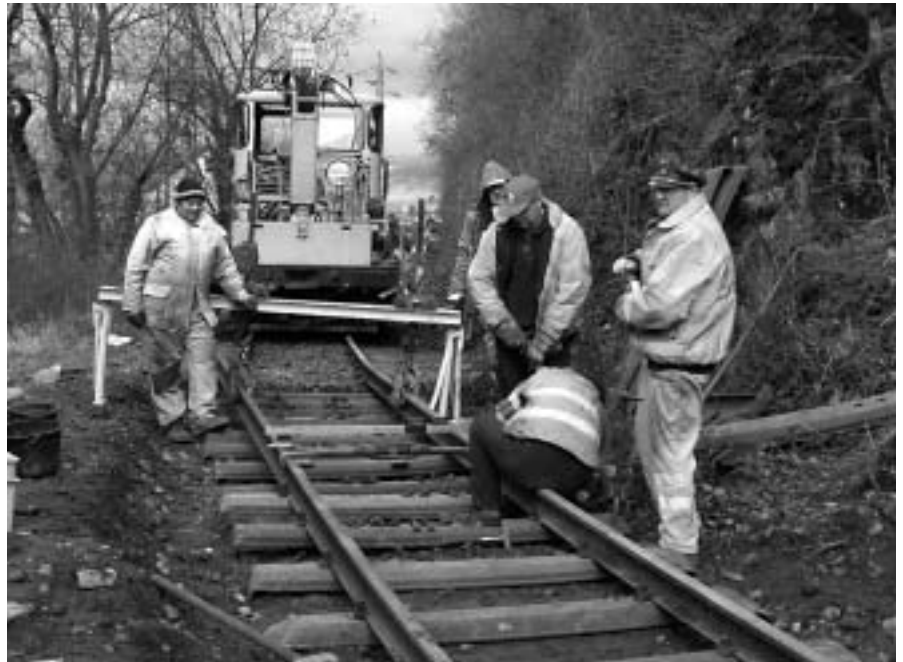
Schwellentausch im Gleisbereich km 0,7 am 25.03.09
