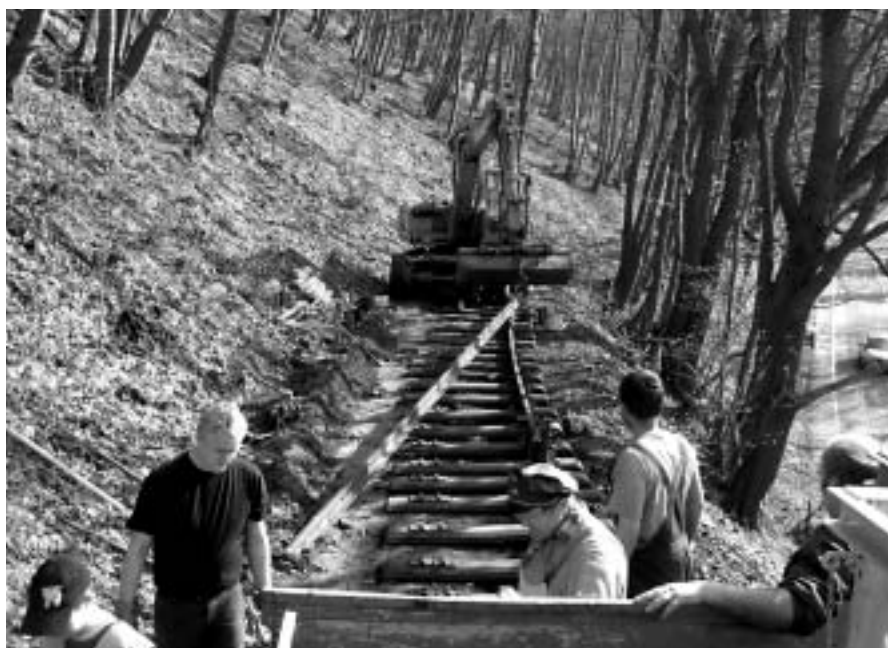
Austausch Gleisjoch am 03.04.09
