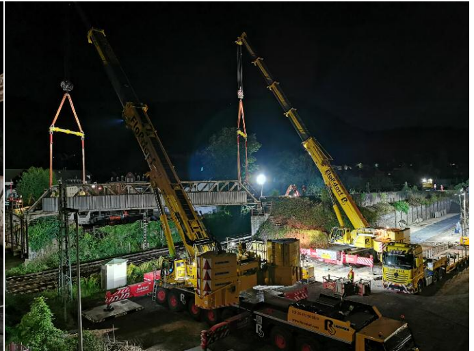
▲ Beide Kräne haben nun Aufstellung genommen und sind bereit zum Ausheben der Brücke. Foto: Tobias Baaden
