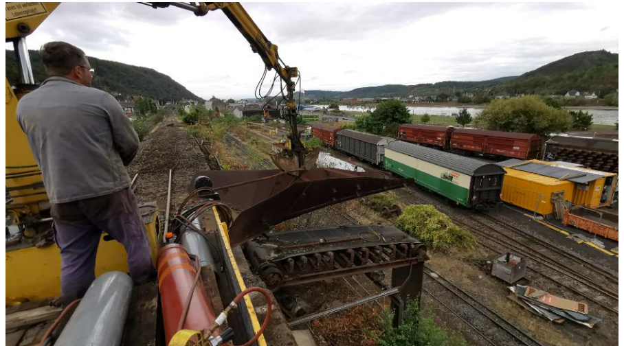
▲ Mit Hilfe des Skl haben Frank Muth und sein Team im Vorfeld des Brückenausbaus am 10. September 2022 das Baufeld geräumt. So wurden u. a. die im Sanierungsbereich gelegenen Gleise auf der Rampe und die alte Bandanlage entfernt. Foto: Tobias Baaden
