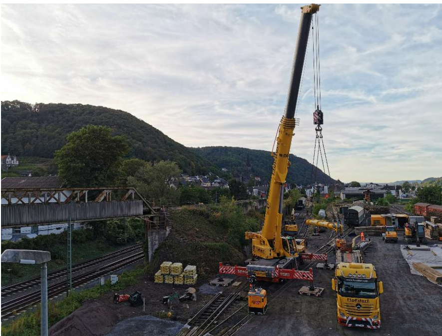
▲ Blick auf den Umladebahnhof vor dem Beginn der Arbeiten: Einer der beiden Autokräne hat bereits Aufstellung genommen. Rechts ist der spätere Ablageplatz des Brückenüberbaus zu erkennen.
