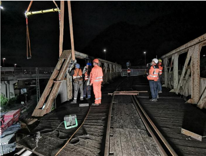
▲ Mit Beginn der Streckensperrung durch die DB begannen die Arbeiten an der Brücke. Die Mitarbeiter des Kranunternehmens verzurren hier die Haltegute an der Stahlbrücke.
