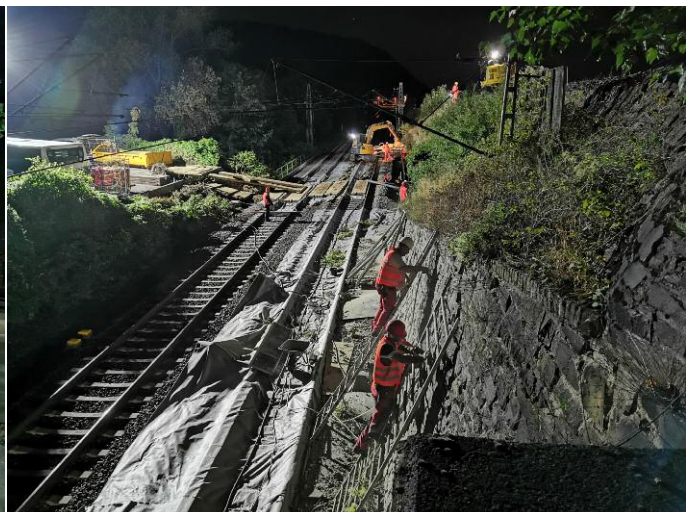
▼ Derweil wurde die Streckensperrung auch genutzt, um die Stützmauern des Rampengleises zu sanieren. Links ist der Zugang über den Busbetriebshof erkennbar. Fotos: Tobias Baaden
