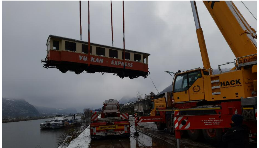
Am 05. Dezember 2022 wurde Wagen 7 nach über 10 Jahren von der Sturzbunkerbrücke im Brohler Hafen heruntergehoben. Per Tieflader ist der Wagen am gleichen Tag zum „Alb-Bähnle“ nach Amstetten transportiert worden, wo ihn eine Zukunft im betriebsfähigen Zustand erwartet. Foto: Frank Muth
