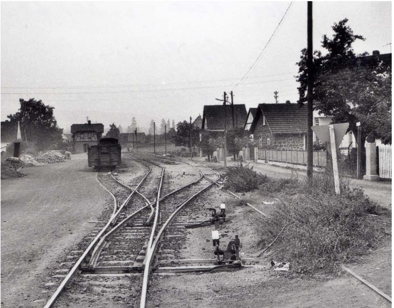
▲ Bahnhof Niederrissen: Perfide Behauptungen zum Auftreten von Niederrissener Juden in den Zügen der Brohltalbahn.
