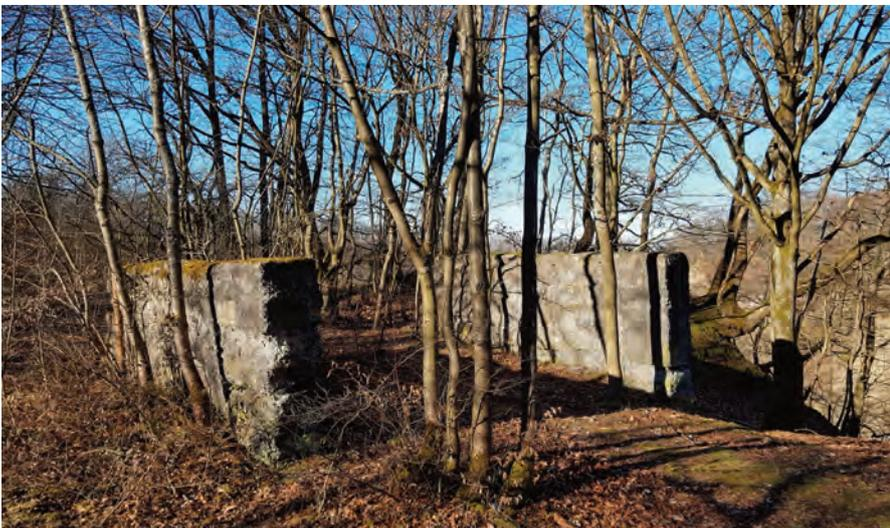
◀ Bild 13: Am Steinberg bei Oberdürenbach findet man im zugewachsenen Gelände des Steinbruchs bis heute alte Verladeanlagen. Vor Ort soll es Bremsberge zum Heraufholen der Basaltsäulen gegeben haben.
