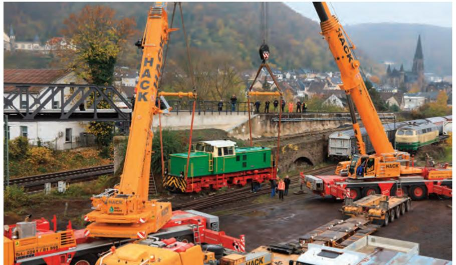
▲ An zwei Autokränen hängend wird die Maschine vom Tieflader auf die Gleise umgesetzt.
