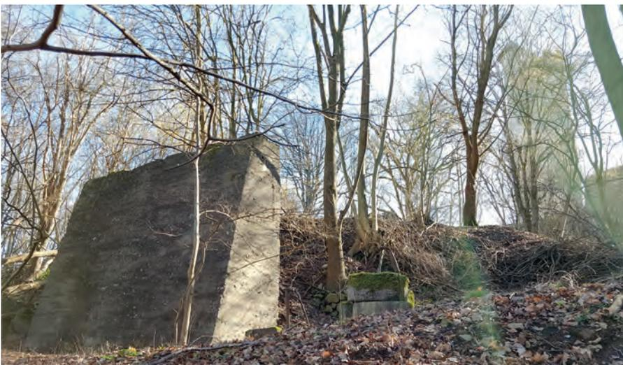
▲ Bild 30: Der gewaltige Sockel der Spannstation Olbrück befand sich nur wenige Meter vom Bergfried der Burg Olbrück (siehe im Hintergrund hinter den Bäumen) entfernt. Er ist bis heute gut erhalten. Die Konstrukteure der Seilbahn nutzen die exponierte Lage des Burgbergs geschickt zur Überwindung der beachtlichen Höhendifferenz zwischen dem Basaltwerk in Oberzissen und dem Steinbruch an der Hannebacher Ley.
