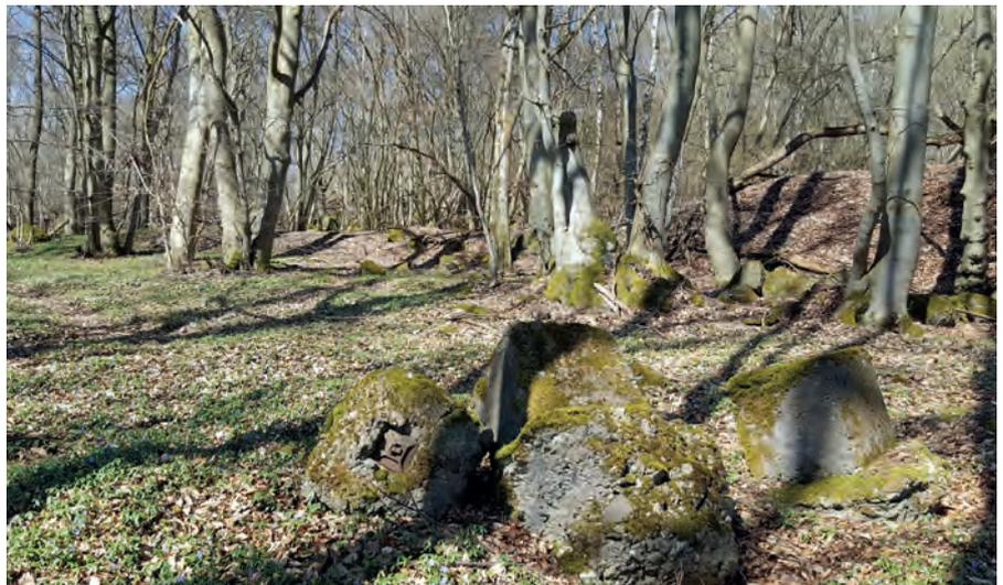
▲ Bild 26+27: Unterhalb der Hannebacher Ley lassen sich im Verlauf der früheren Seilbahntrasse an mehreren Stellen die Betonsockel ausmachen, auf denen die Tragmasten der Seilbahn montiert waren. Bilder (21. Februar 2021): Volkhard Stern
