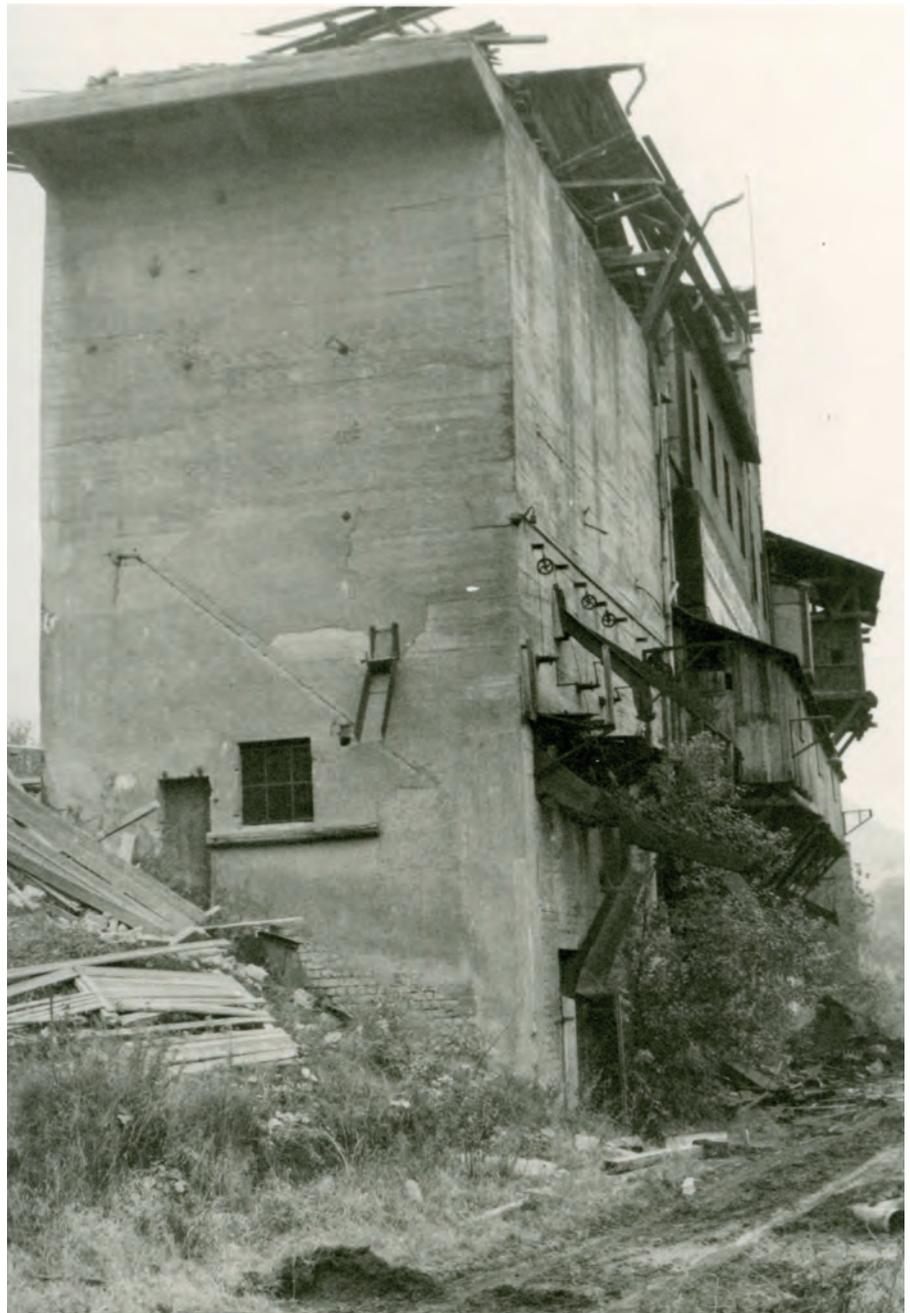
▲ Bild 24: Abriss des Basaltwerkes Oberzissen im Jahr 1975. Die Schüttrutschen, unter denen die Waggons beladen wurden, sowie Gleisreste sind zu erkennen. Bild: Alfons Dietz
