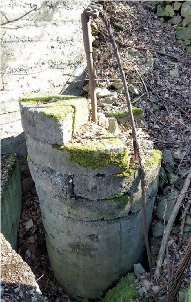
▲ Bild 31: Die tonnenschweren Gewichte der Spannstation dienen dazu, die Seile stramm zu halten. Sie sind unterhalb der Burg Olbrück ebenso erhalten wie Reste des geflochtenen Drahtseils.
