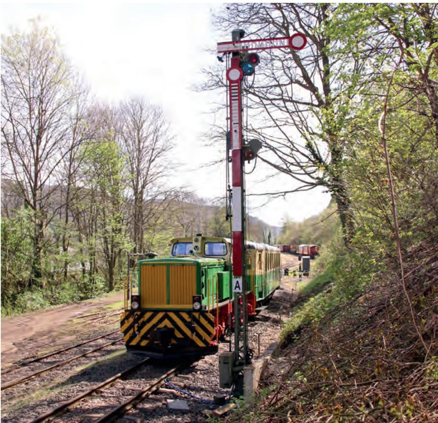
Am 19. März 2024 war es dann soweit: Nach dem Vorbild des 46 Jahre zuvor abgebauten Signals wurde der neue, grün gestrichene und mit rot-weißem Schild versehene Signalmast an alter Position errichtet, komplett mit den dazugehörigen Seilzügen, Spannwerk und Spanngewicht sowie Signalbeleuchtung für die dunklen Stunden des Tages.
