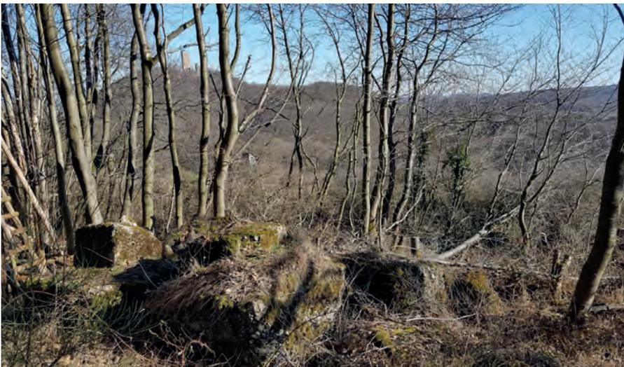
◀ Bild 29: Unmittelbar vor dem Steilhang, der ins Tal des Brohlbaches hinabführt, finden sich Reste der Betonkonstruktion, auf denen der Tragmast der Seilbahn montiert war. Von hier aus ging es beachtliche 735 m frei schwebend in Richtung Burg Olbrück, deren Bergfried man zwischen den Bäumen erkennt.
