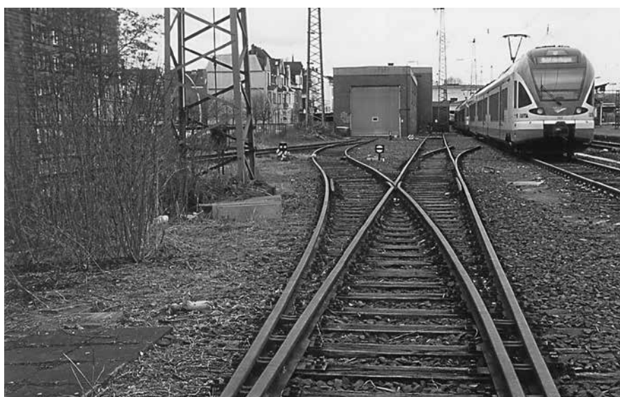
Gleise 102 (links) und 27 vor (Bild oben) und nach der Rodung. Gleis 102 in der Halle (Bild o. r.) ist über eine Rampe von außen zugänglich
