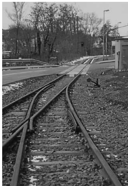
Erneuerte Weiche 2 Foto: Michael Baaden
