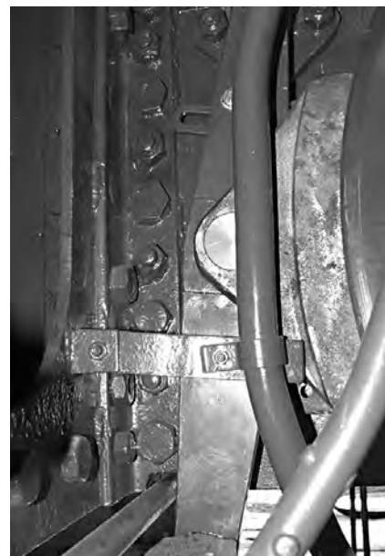
Die Bremsklötze sind montiert, die Zugänglichkeit ist allerdings nicht einfach.
