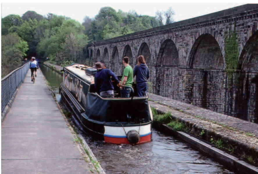
Aquädukt und Eisenbahnbrücke am Llangollen Canal in Chirk
