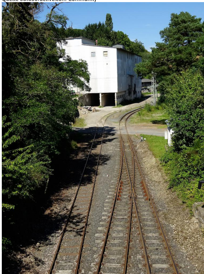
Blick auf die Werksanlagen in Brenk.
